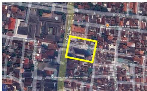
Gambar 6. Lokasi Gedung Hotel Oakwood Yogyakarta
