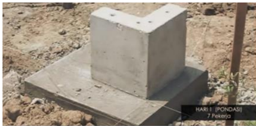
Gambar 3. Pondasi Setempat RISHA (Sumber PT. Indocemen)
