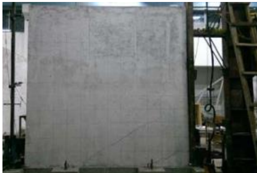
Gambar 9. Bentuk kerusakan dinding batu bata eksperimen
