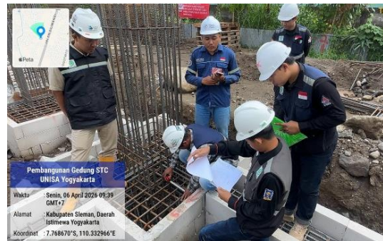
Gambar 1. Inspeksi pekerjaan Tie Beam
